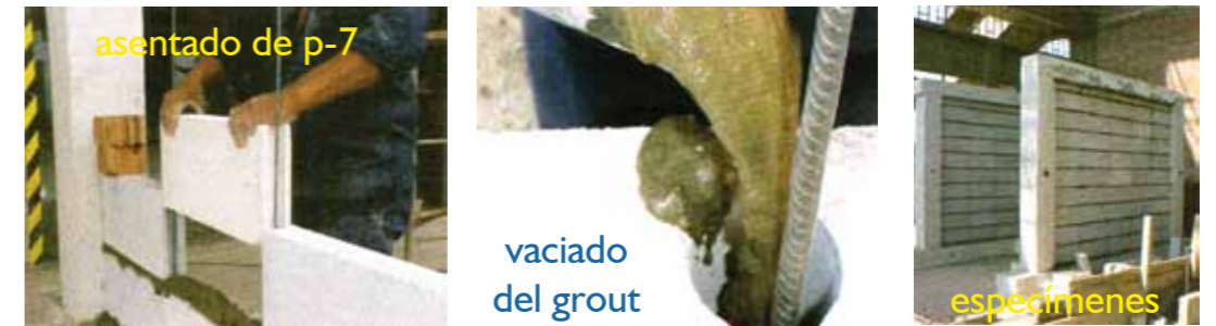
Fig.4. Construcción del tabique con Placa P-7.
