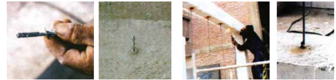
Fig.3. Perno expansivo y soldadura con las varillas del tabique.
