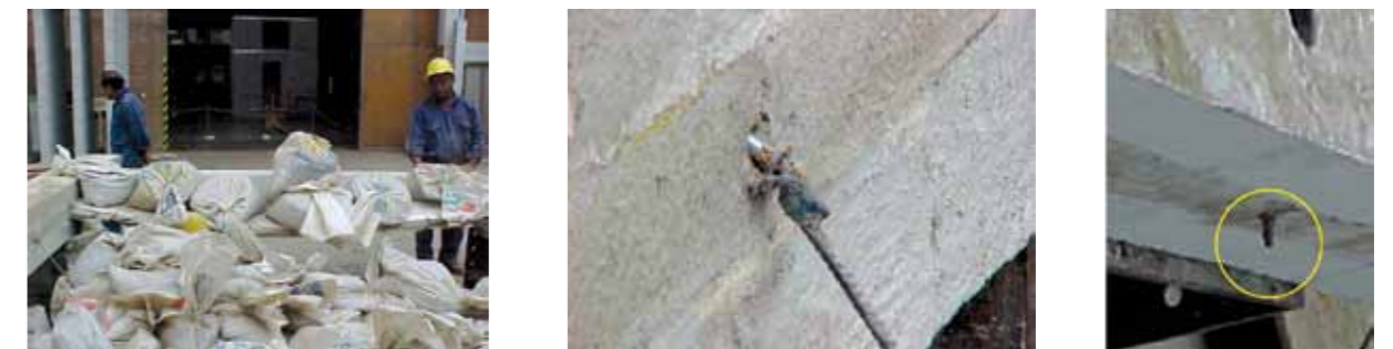
Fig.11. Colapso del tabique (izq.), falla por anclaje del perno expansivo (centro) y falla en el punto de soldadura perno-refuerzo vertical del tabique (der.).
